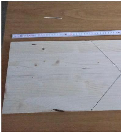
Abbildung 1: Anzeichnen der Schnittlinie
