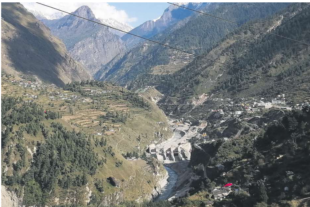
Opfer der Sturzflut: ein zerstörtes Wasserkraftwerk im Tal des Dhauliganga
